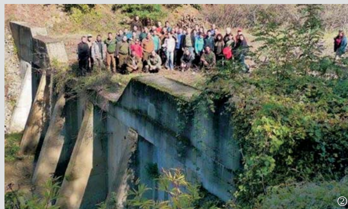
Стоманобетонен бараж в пороя Марулевска река
