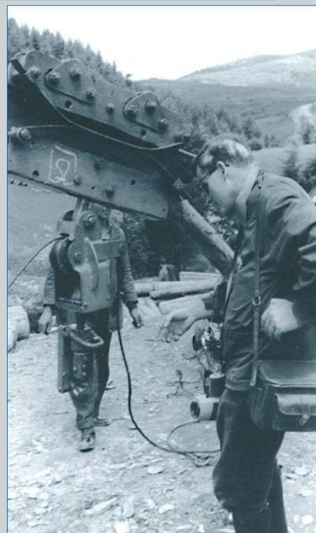
Сн. 1. Транспортиране на дървени материали с полустабилна въжана линия в Осеново (1956 г.)
