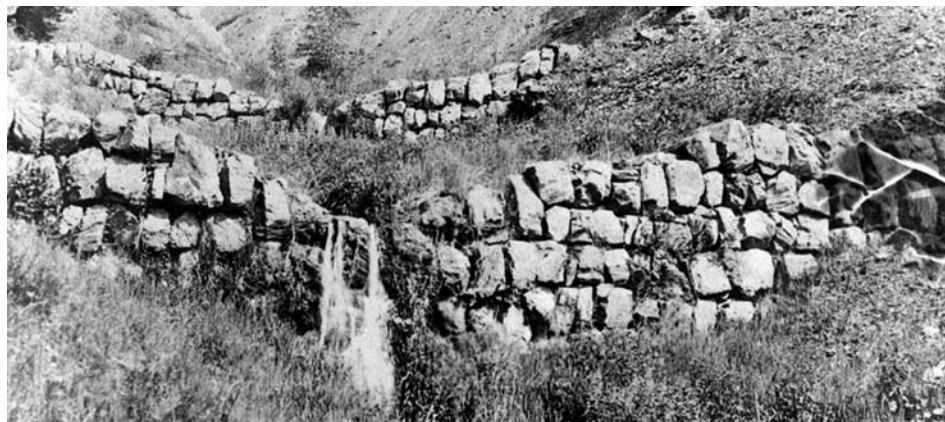
Първият бараж и първият овладян пороен водосбор - Гръцко дере, край с. Шипка, в началото на XX век
