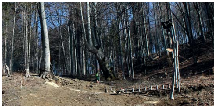
Долна станция на въжена линия с дължина на трасето 1300 м в отдел 48 а. Извежда се групово-постепенна сеч, окончателна фаза, на 8.9 хектара
