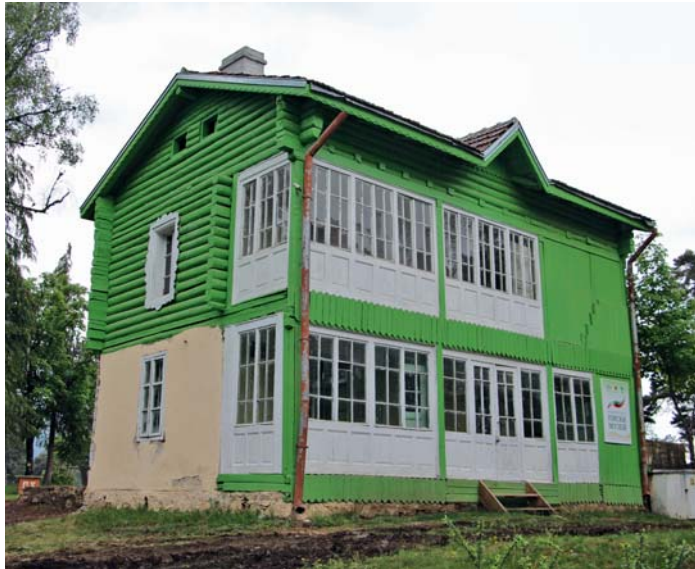
Ремонтът на сградата продължава и вън, и вътре
