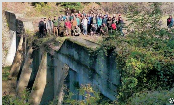
Стоманобетонен бараж в пороя Марулевска река
