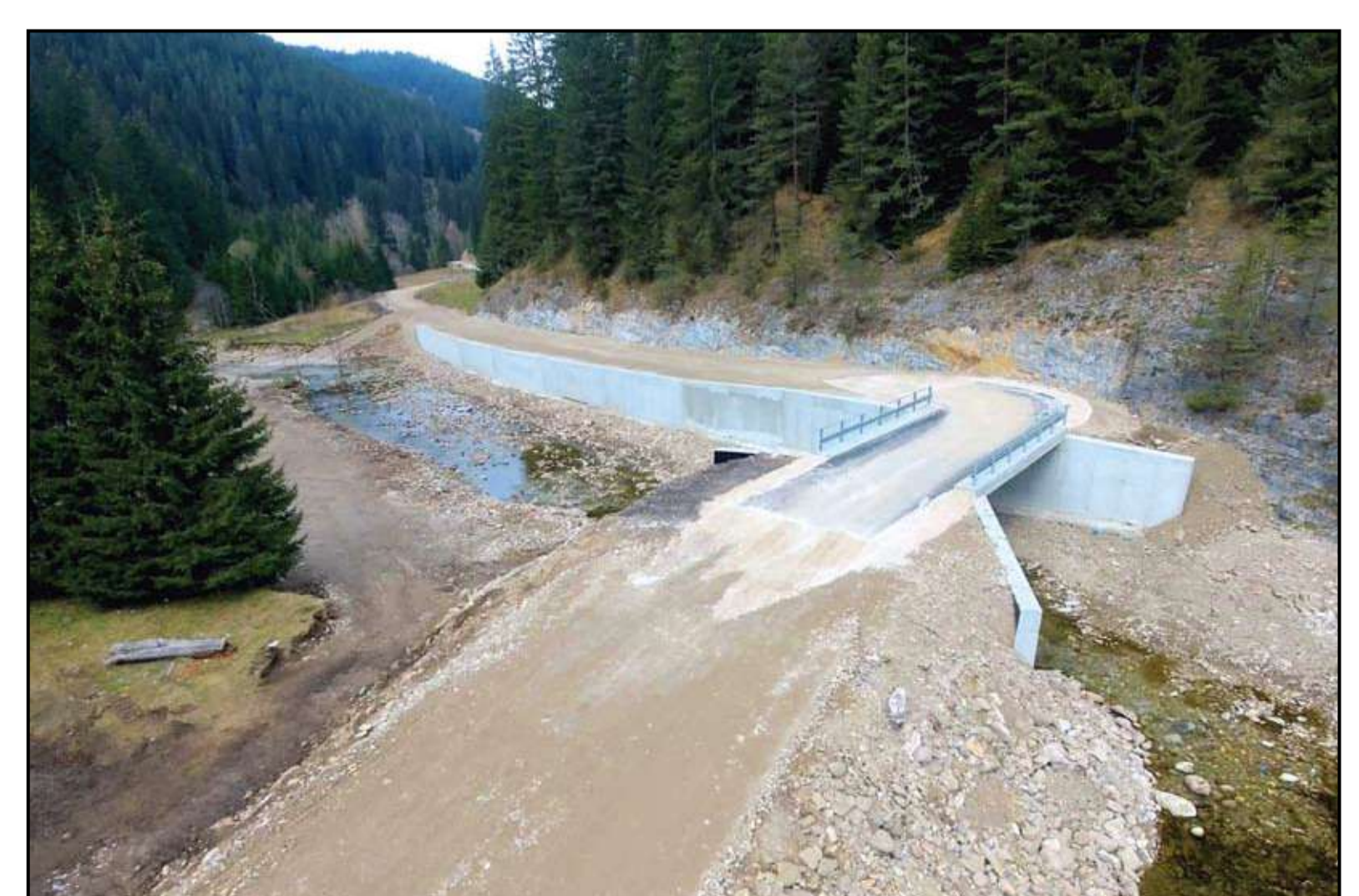
Изграден горски път в местността Тешел – от ДАС „Избора“ – Девин, до ДГС – Смолян, Южноцентрално държавно предприятие – Смолян, 2023 г.
