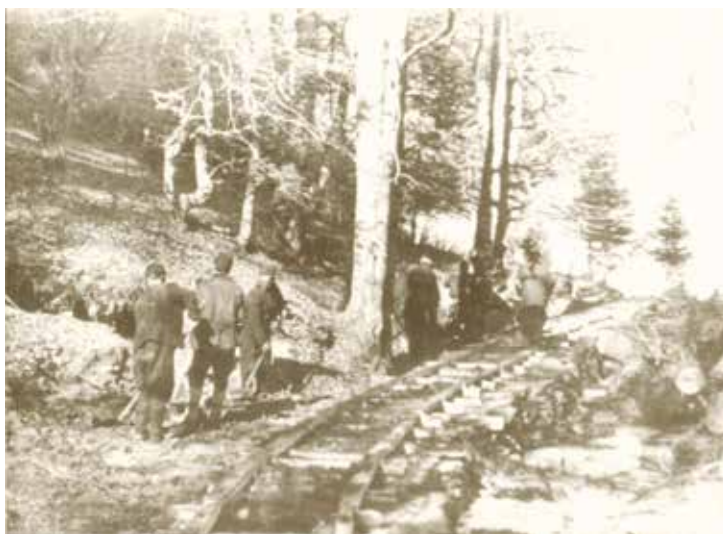
Извозване на дървени материали по дековилната линия в м. Величка река. Връщането на вагонетката се е извършвало с използването на животинска тяга (волове)
